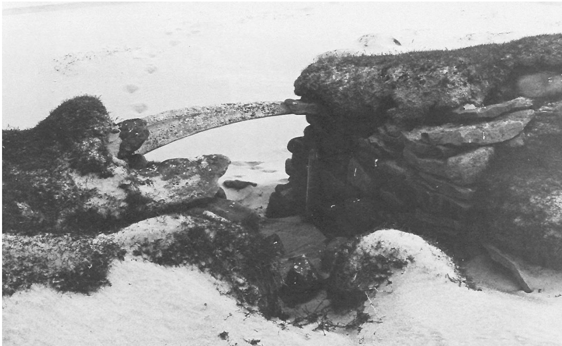
Figur 7.8. Hvalbein som bjelke over døra tili en værbod til nedfalls i Breiðuvík, i Vestfjorden, Island. Mulig analogi til inngangspartiet i Skonsvika? Foto: Hörður Ágústsson. Fra Kristjánsson 1982:426, fig. 447
