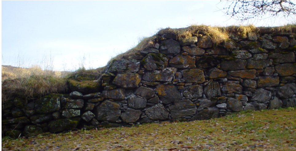
Figur 8. Fall i høyde og endring i murverk i nordøstmuren. Foto: IS
