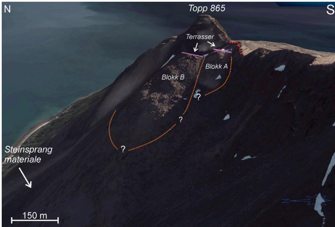
Figur 56. Tolkninger med baksprekk i rødt, antatte grenser for blokk A og B i oransje, og terrasser i rosa. Tegnforklaring i figur 13. Foto: Norgei3D.
