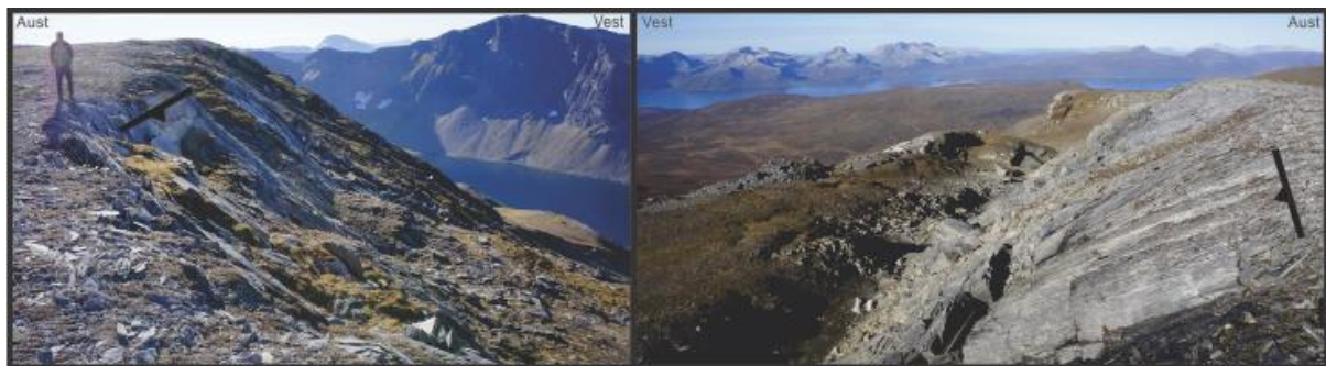
Figur 49. Bilder av området i toppen av del B i Trollskredet. Her har foliasjonen fungert som glideplan. Foliasjonen foldes over kanten og blir brattere. Bildet er tatt fra samme punkt, motsatt retning. Etter Sandnes (2017).
