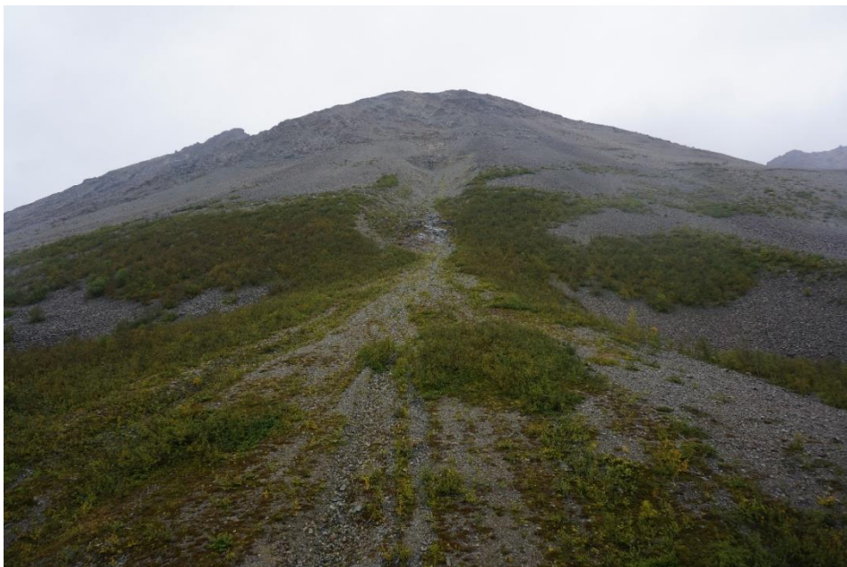
Figur 75: Bilde av skredviften, ravinen og resten av kildeområdet. Bildet er tatt fra punkt 1 på Figur 83
