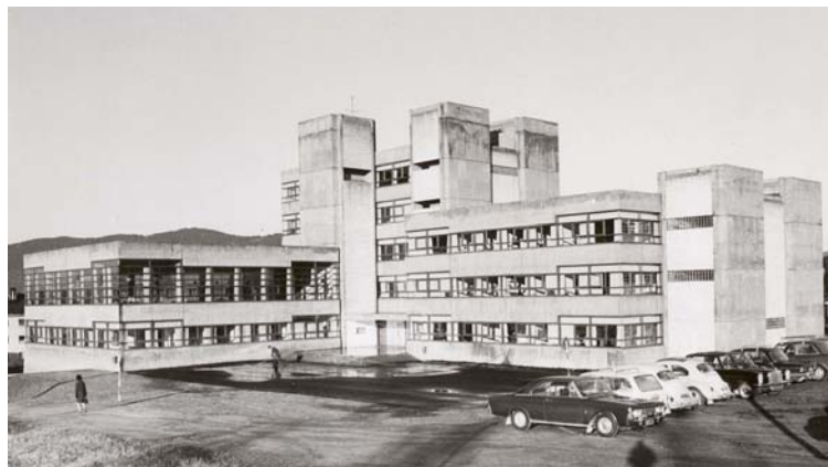
Rådhuset i Mo, slik det sto etter første byggetrinn i 1969. Foto Nasjonalmuseet; Stiftelsen Arkitekturmuseet
