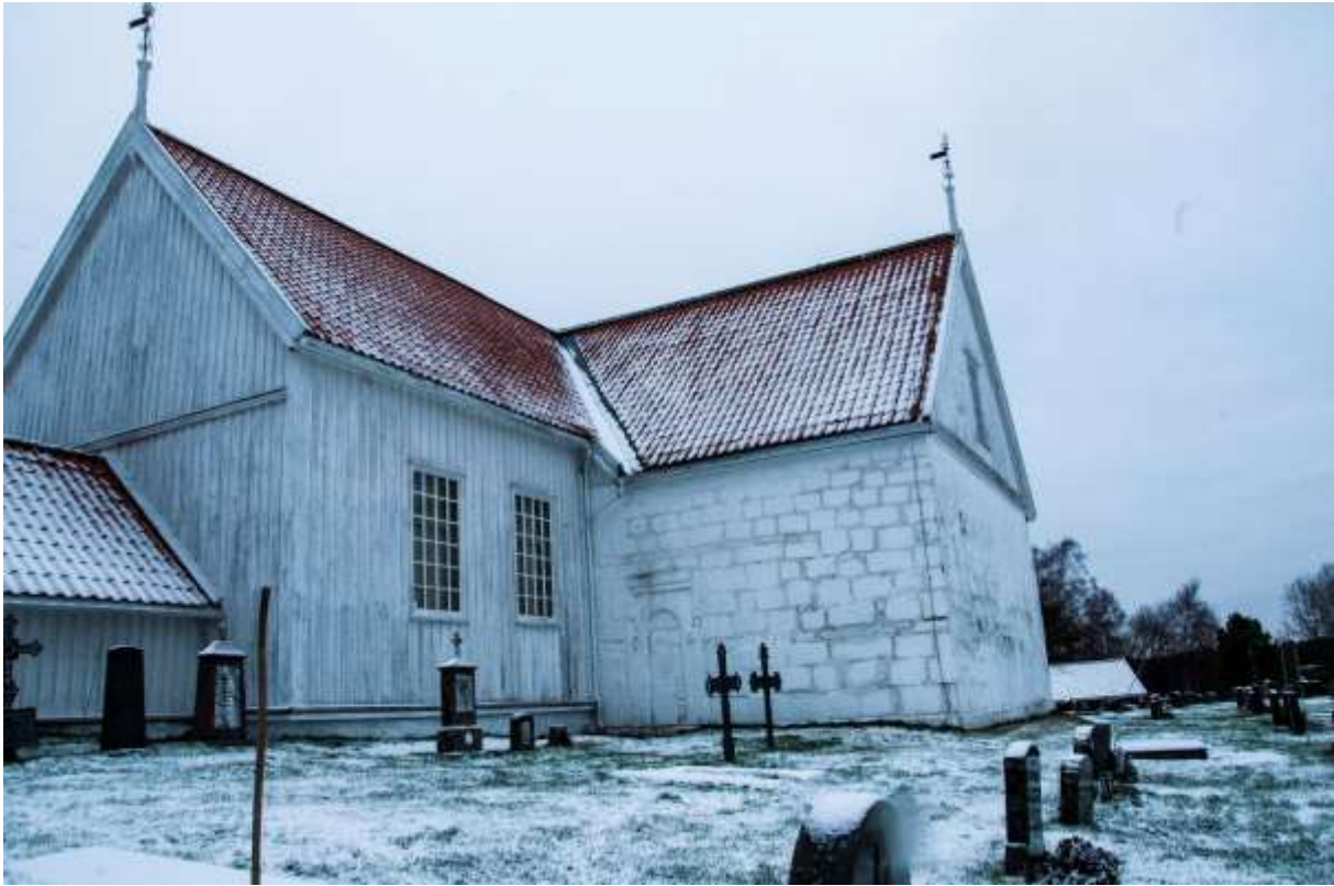
Fig 1. Tromøy kirke sett fra sørøst. Det er sørveggen i den nåværende østfløya som viser oss de fleste indikasjonene på ei komplisert bygningshistorie. Foto RB 2018
