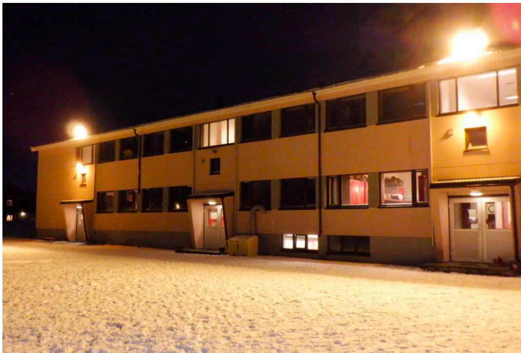
Figur 3.1. Bilde av fasade av hovedbygget til Bygg A. Hentet fra miljøkartleggingen Halka kaserne, fra Multiconsult.
