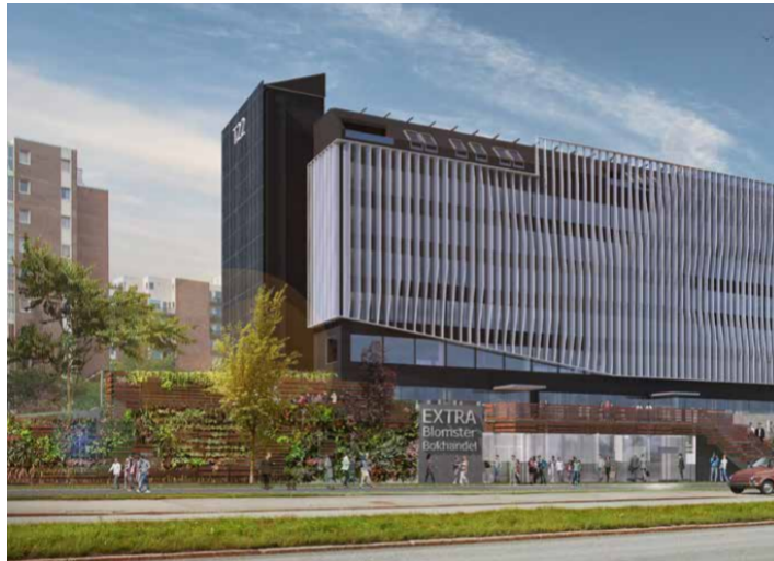
Figur 2.4 Max bygget i Trondheim. (Byggalliansen, 2019)
