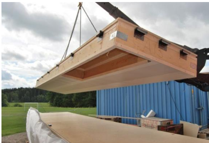
Figur 3-14. Gulvelement/etasjeskille av tre. Bilde hentet fra https://www.produktfakta.no/lattelement-ab/lattelement-bjelkelag/produkt.html .
