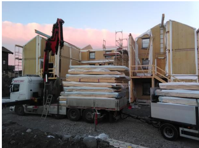
Figur 3-5. Bilde av kranbil med prefabrikkerte elementer av tre. Privat foto.
