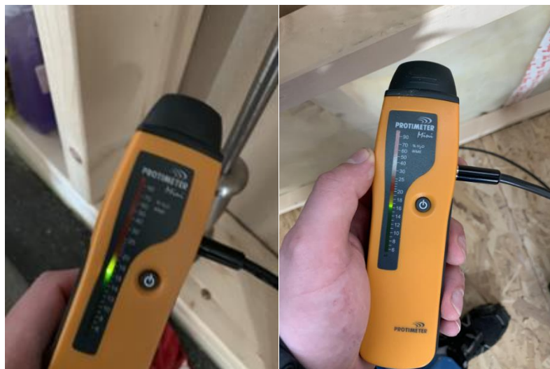
Figur 2-6. Bilde av fuktmåling av bunnsvill (venstre) og fuktmåling av stender (høyre). Privat foto.
