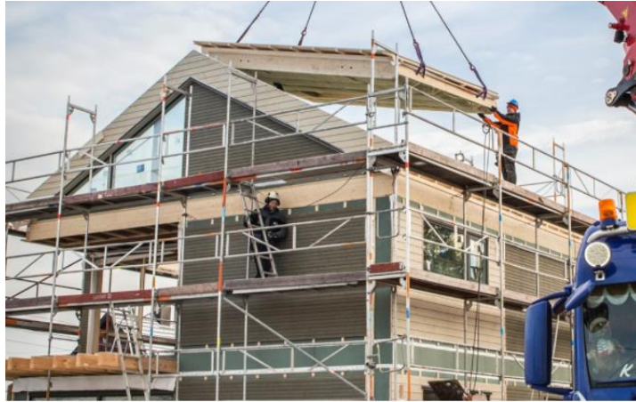
Figur 3-12. Takelement av tre. Bilde hentet fra https://www.optimera.no/nyheter/nyhetsarkiv/fremtidens-byggemetode/ .
