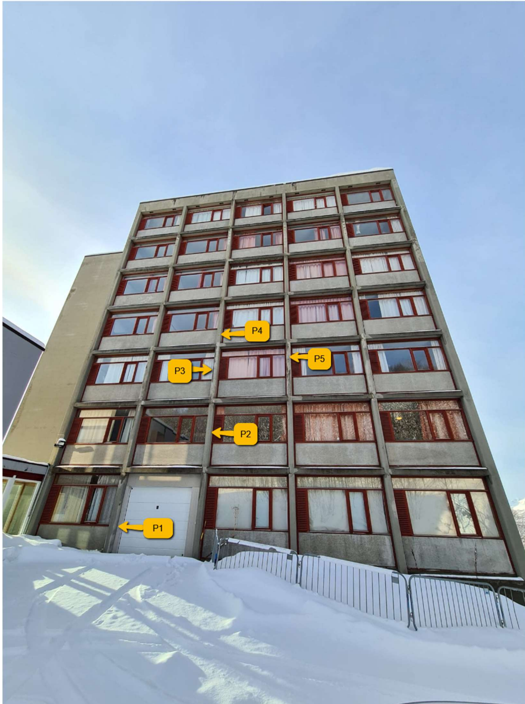
Figur 32. Prøvehull P1-P5 østfasade.
