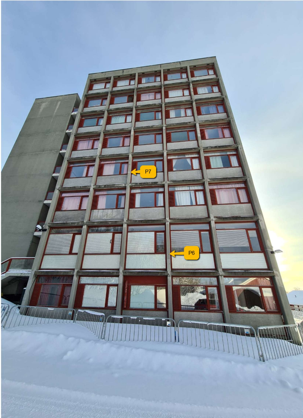
Figur 33. Prøvehull P6-P7 nordfasade.
