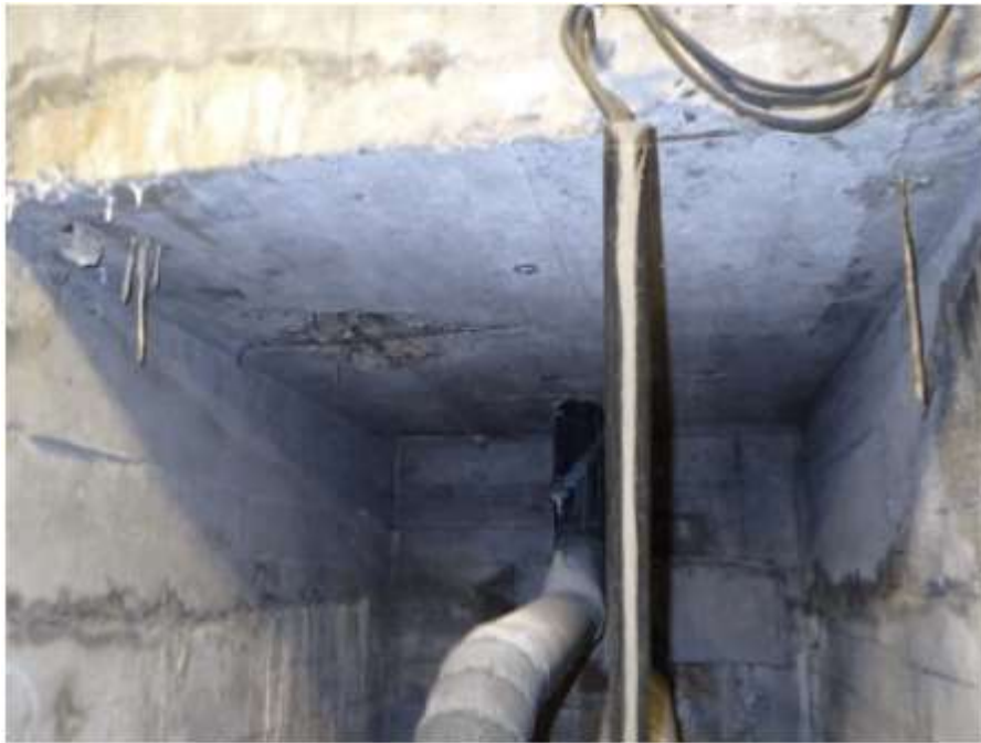
Figur 14. Utluting har dannet stalakitter av sementlimet (Millab Consult AS, u.d.).
