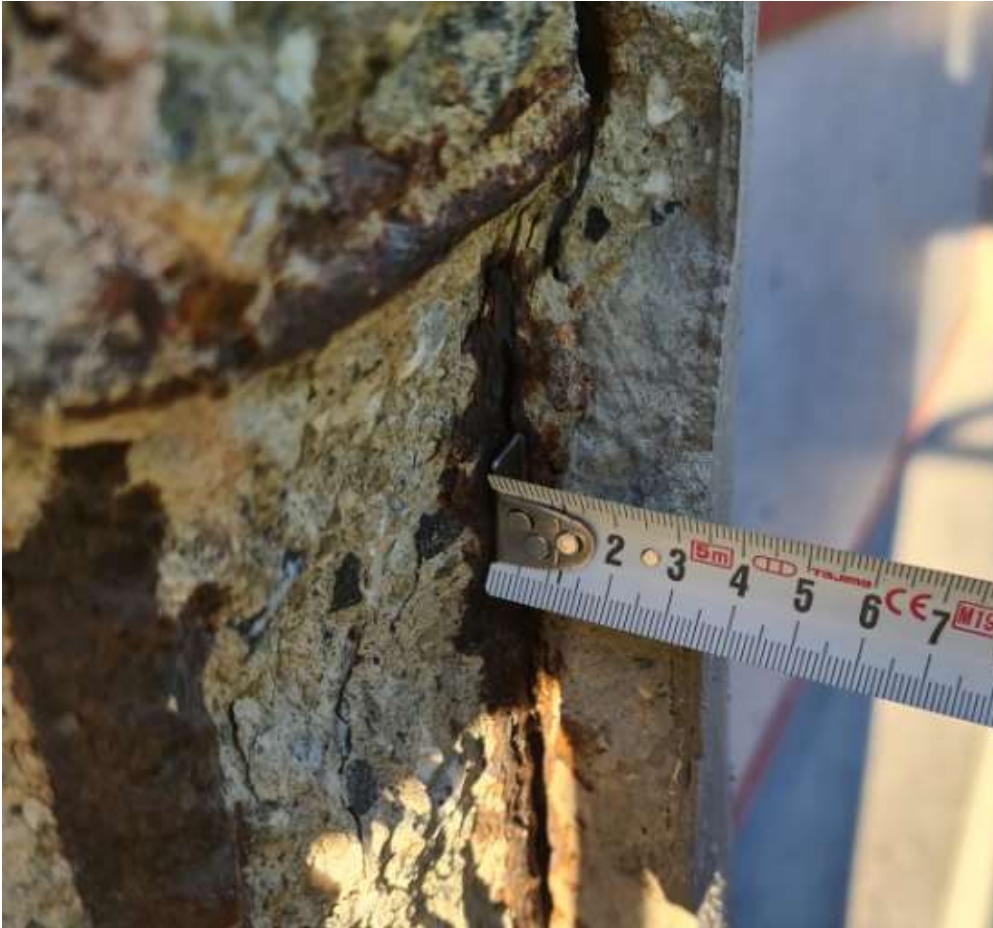
Figur 23. Overdekning skadd søyle plan 3.
