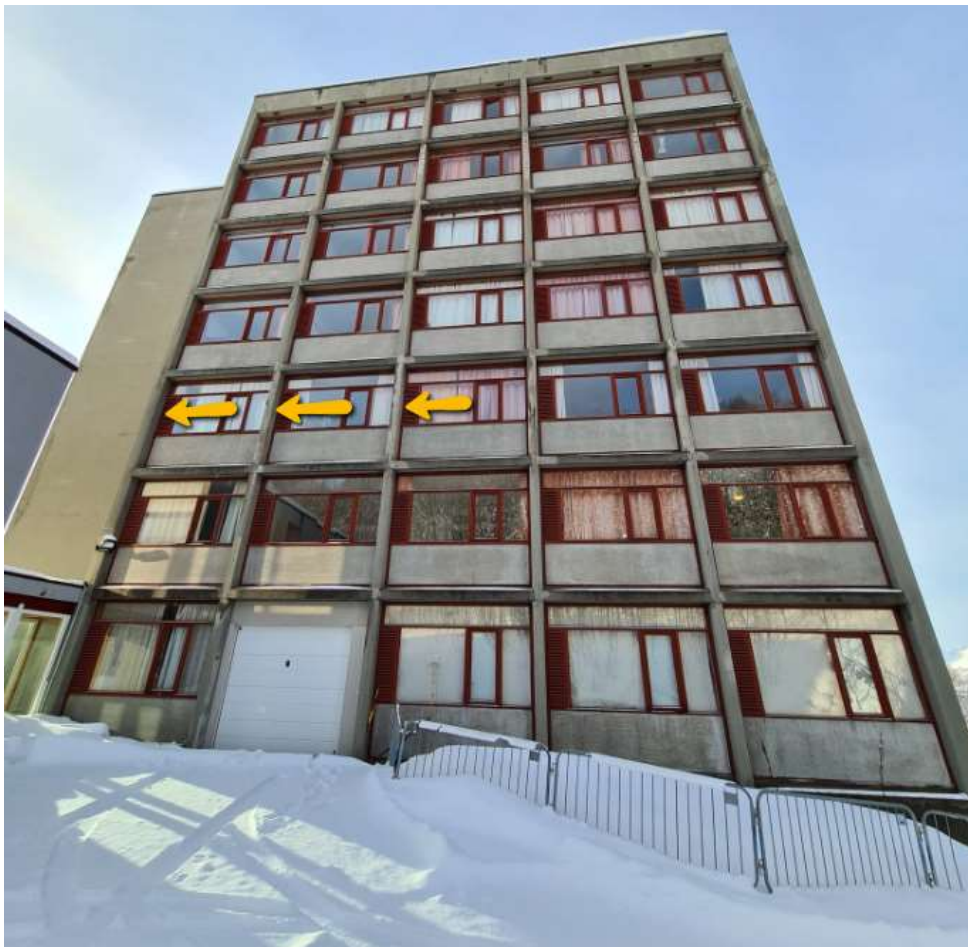
Figur 29. Lokasjon for karboniseringsprøver østfasade.
