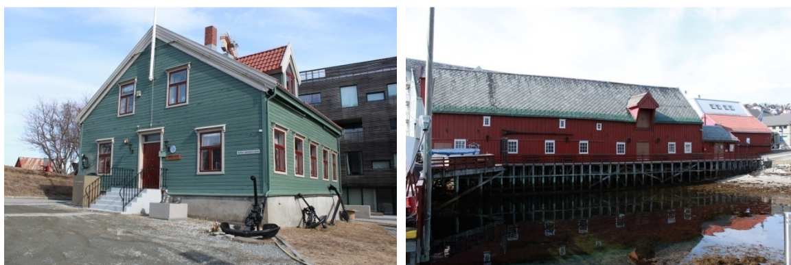
Figur 5. Bildet til venstre : Tollvesenets kontorbygning. Bildet til høyre : Tollbodbrygga med Polarmuseets lokaler. Møllerfjæra i forgrunn. Foto: Ragnhild H. Nergaard.
