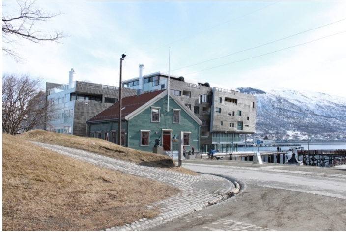
Figur 7. Tollbodstranda leiligheter med Skansen-vollen og Tollvesenets kontorbygning i forgrunn. Bildet tatt mot sør-øst. Foto: Ragnhild H. Nergaard.
