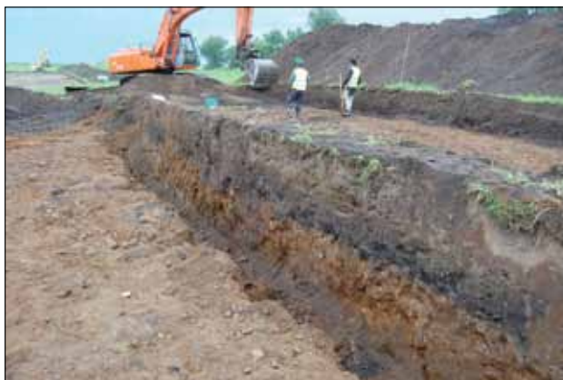
Figur 169. Flateavdekking i dyrkningskråninga på det midtre feltet. Her ses den lange profilbalken som ble satt igjen i midten av utgravningsfeltet. Foto: Ingrid Sommerseth.
