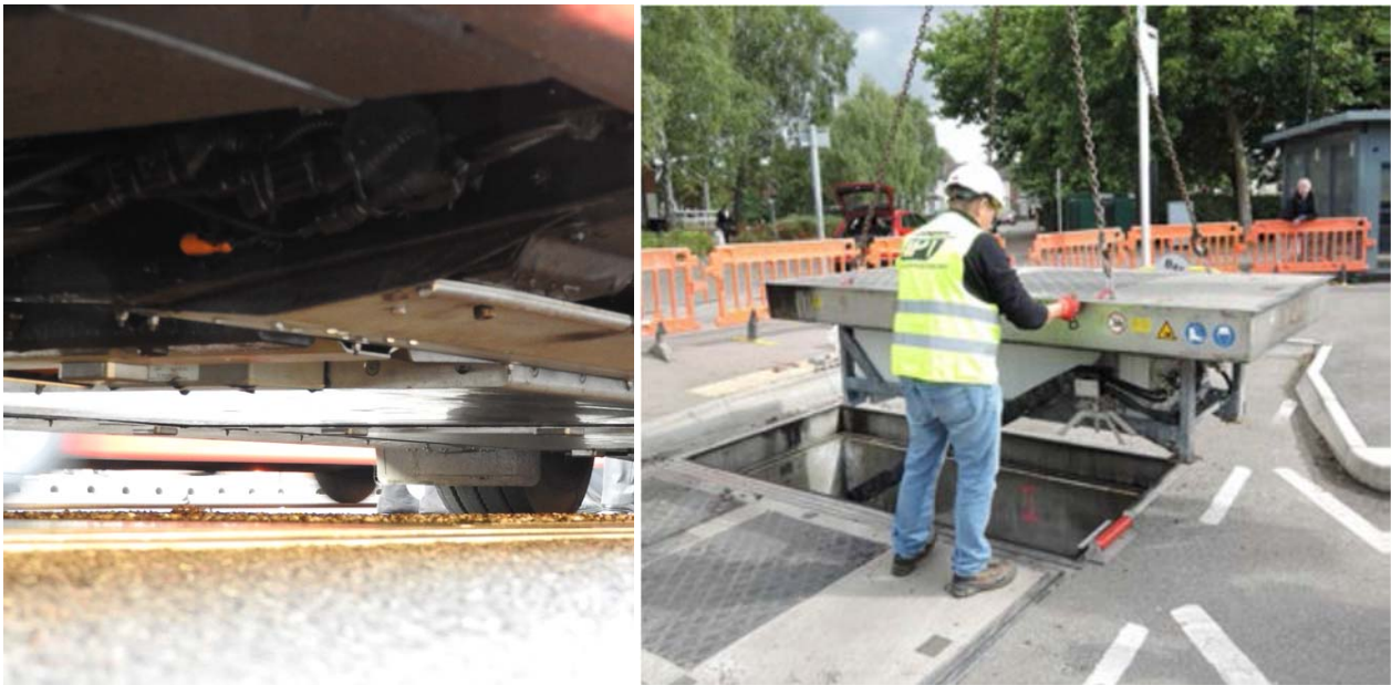
Figur 27: Installasjon av ladeplater om bord på buss og i veibanen (Bilder: www.ipt-technology.com )
