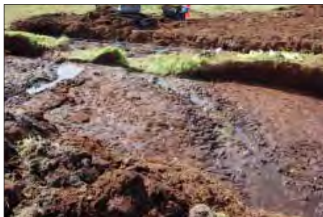
Figur 4.8.4. Vannet fant naturlige vannveier gjennom felt A, og dreneringsgrøfter ble gravd i nedkant av feltet. Foto tatt mot V (foto: Siv Henriksen©Tromsø Museum – Universitetsmuseet).
