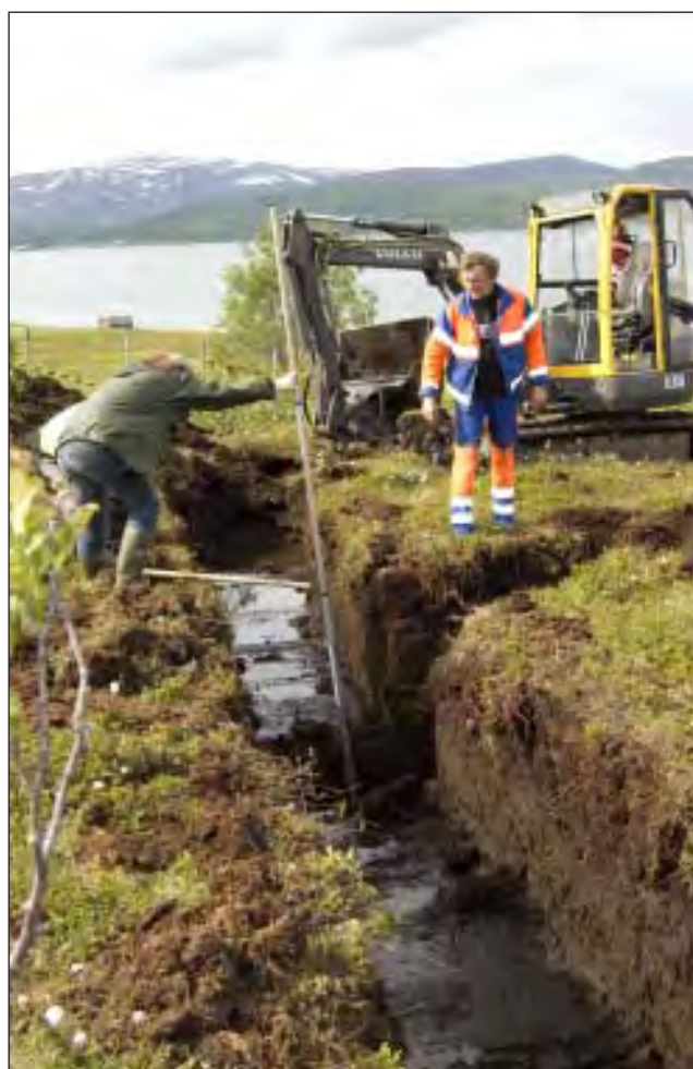
Figur 4.9.3. Nivellering av terrengoverflaten under torvlaget i dreneringssjakt (foto: Marianne Skandfer©Tromsø Museum – Universitetsmuseet).
