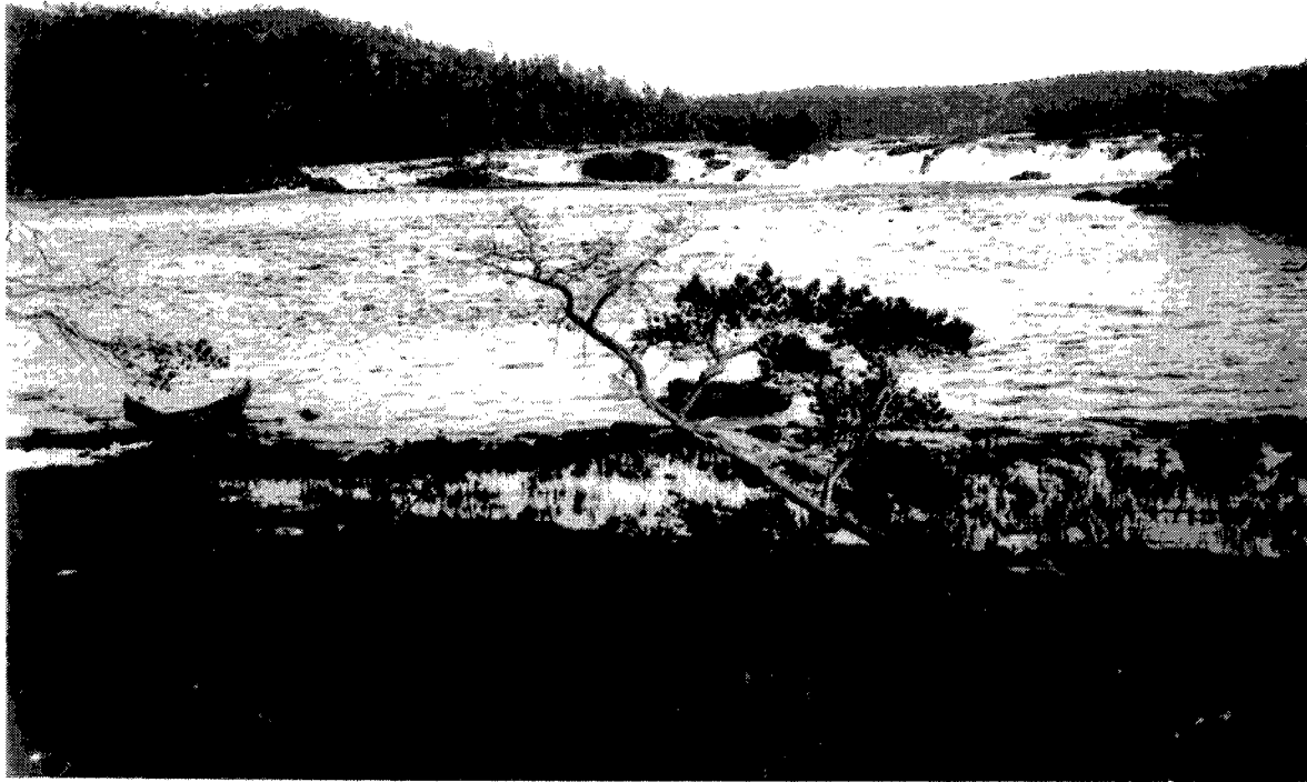
Figur 10. Foto av Mennikkakoski før oppdemmingen. Foto: E. Wessel 1900
