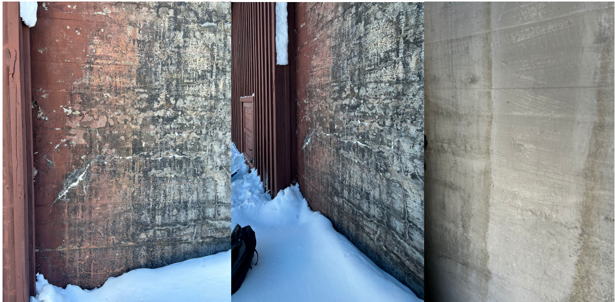
Figur 23. Betongkonstruksjonen Nygårdsdammen. (Foto: I.E.A.Hjallar, Mars, 2023)
