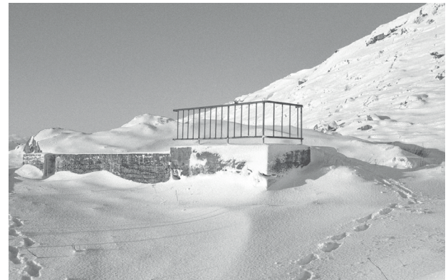
Grunnmuren til det gamle skolebygget som kollapset i 1974.
