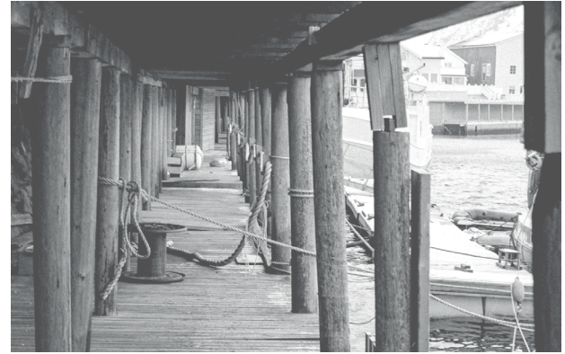
Gjennopbygde brygger, bygd i to etasjer
