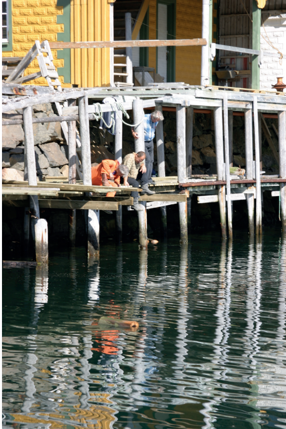
Foto: Atle Valland 2003, gjenoppbygging av brygge
