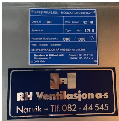
Data ventilasjonsaggregat
