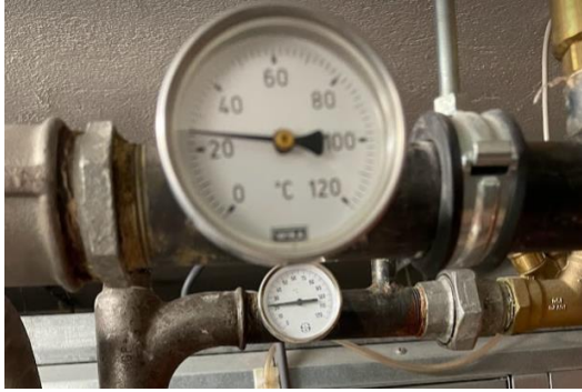
Returtemperatur varmebatteri
