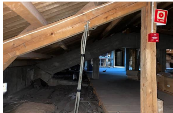
Bæresystem i tre og betong i takkonstruksjon
