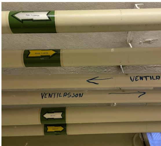
Tur-retur varmebatteri og radiatorkrets
