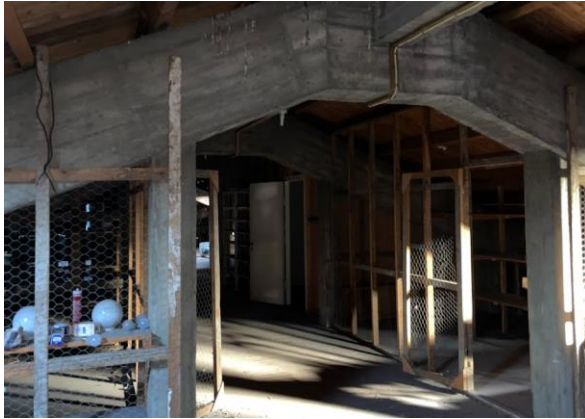
Bæresystem i betong i tak
