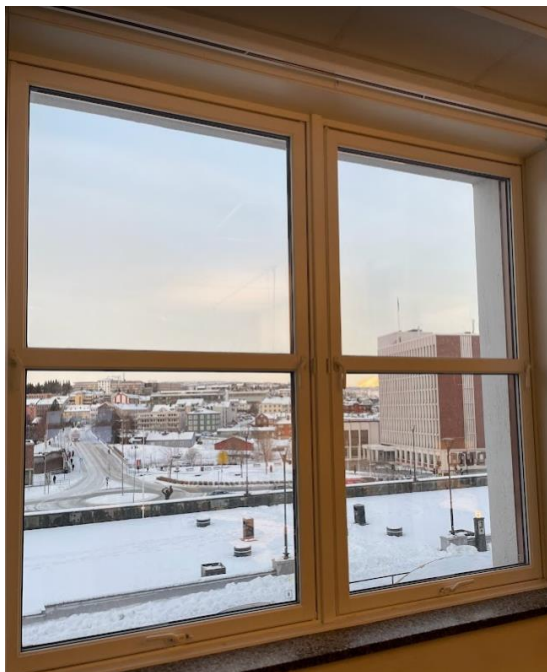
Vindu 2-4. etg vest og østside, årgang 2018, inkl. innvendig solskjerming
