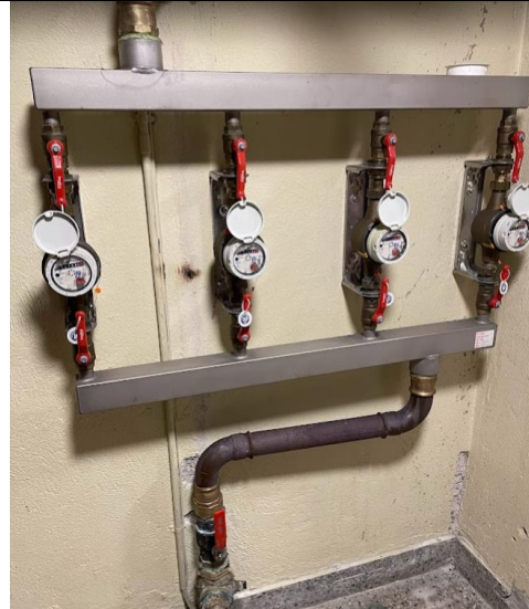
Vannmåler kjeller
