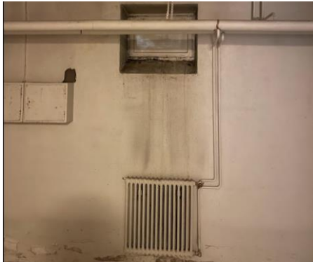
Rørisolasjon radiatorkrets
