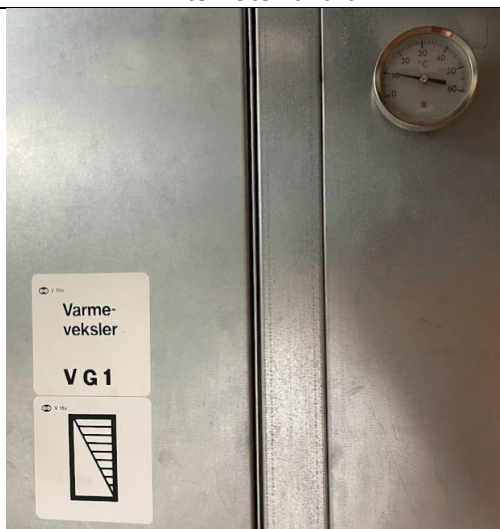
Avtrekkslufter etter varmegjenvinner
