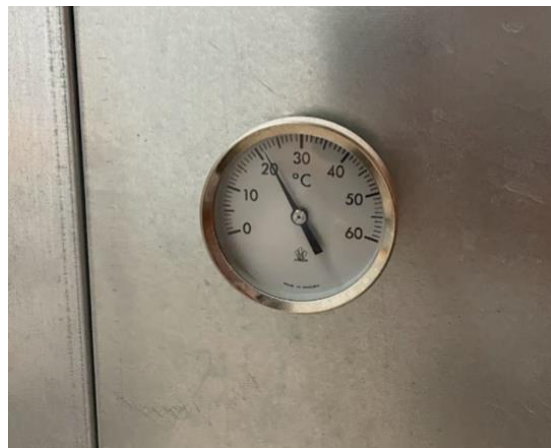
Temperatur etter varmegjenvinner og varmebatteri
