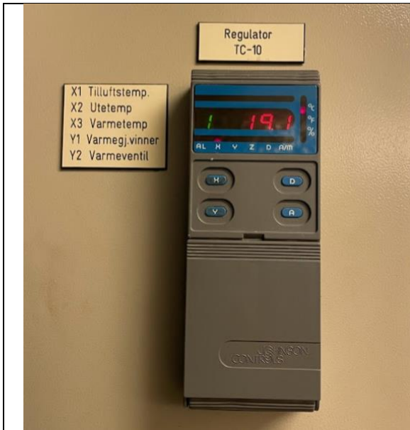
Registrert tilluftstemperatur
