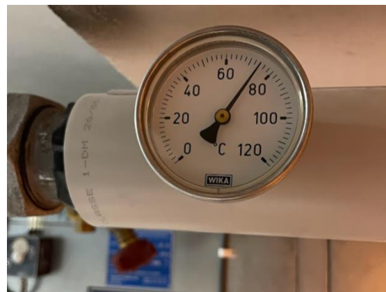
Turtemperatur varmebatteri
