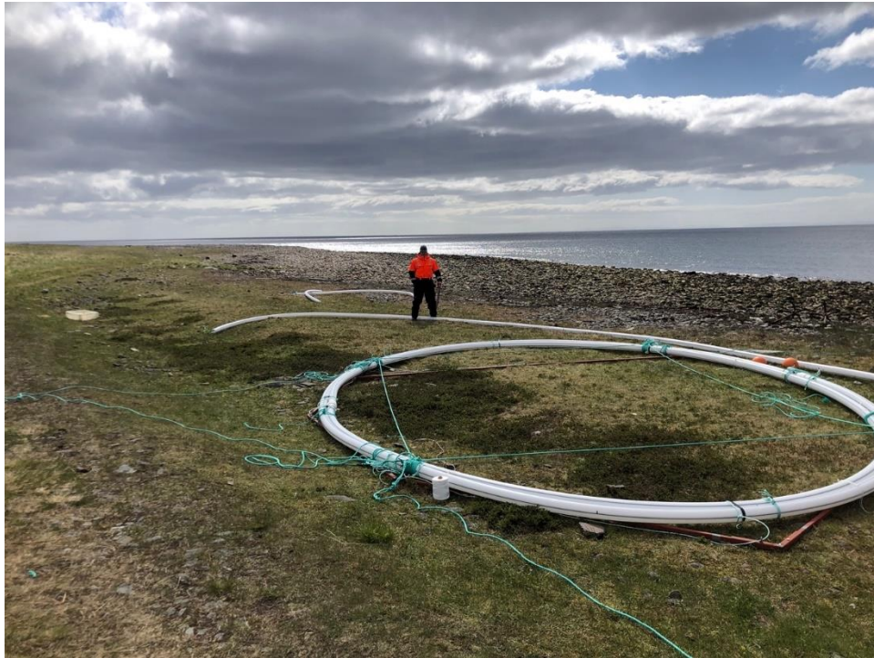
Figur 19: Flyteringen ble laget i fjæra ute ved lokaliteten Manahaug. På bildet vises firepunkts avstiving av ringen med tau. Bildet viser også bunnringen som ligger under flyteringen. Foto: Simon Eliseussen.
