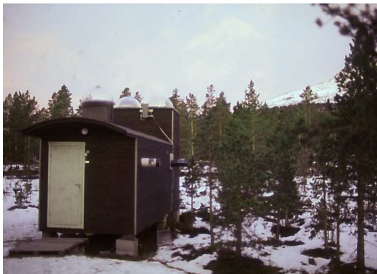
Figur 8.8 Ove Harangs Nordlysobservatorium flyttet opp fra Olderbakken.
