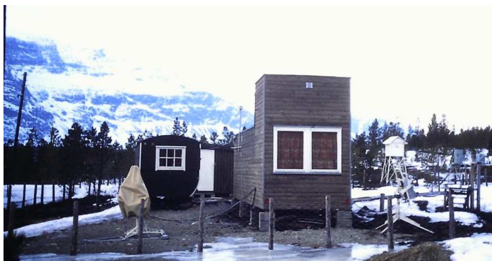
Figur 2.3. Nordlysobservatoriet på Olderbakken. Vi ser en rekke instrumenter plassert i terrenget og en av de transportable hyttene og meteorologiburet som ble brukt på fjellstasjonene. I på taket av den høye delen ble det montert kupler for all-sky kamera. Ove hadde soveplass under en av kuppene.
