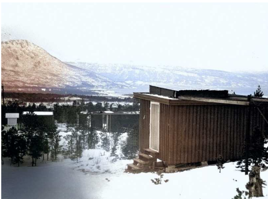
Figur 2.5. Observatoriet på Olderbakken. Vi ser det astronomiske observasjonsbygget med flatt tak i forgrunnen og lenger nede Nordlysbrakka som nå har fått kuppel også i den andre enden.
