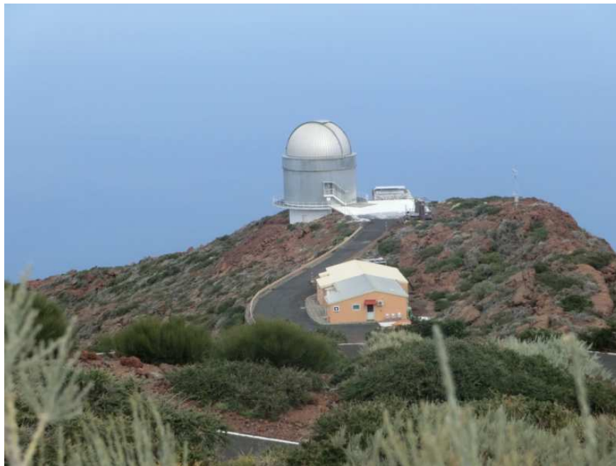
Figur 9.14. Nordisk Optisk Teleskop (NOT) på La Palma. Til høyre for teleskopbyttet ser vi bygningen til den delvis underjordisk infrarød spektrograf som får lys fra teleskopet gjennom optisk fiber. Bygningen i forgrunnen er servicebygningen med kjøkken, oppholdsrom og verksted. Foto: Kari V. Knutsen
