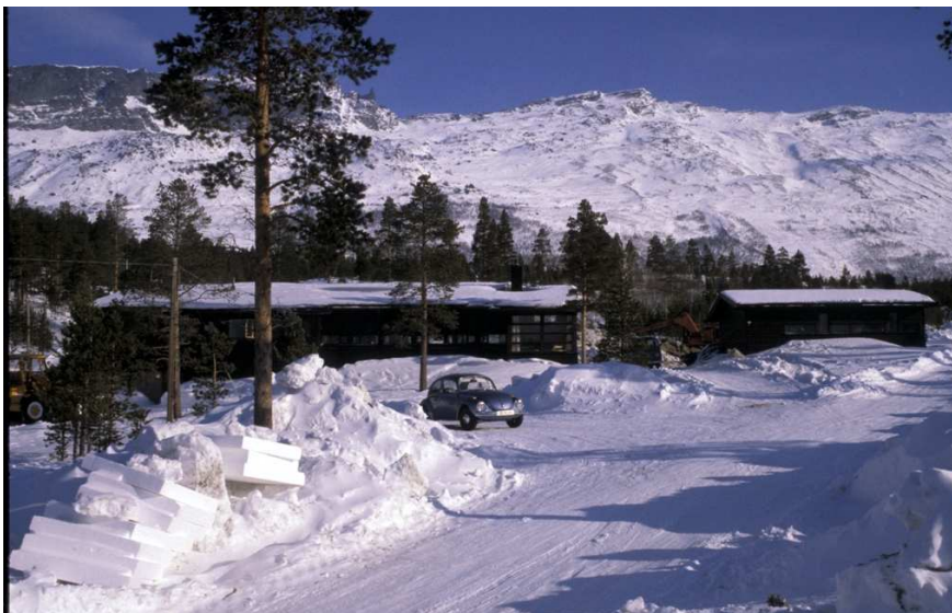
Figur 8.11 Skibotn feltstasjon med hovedbygg til venstre og hytte C til høyre.
