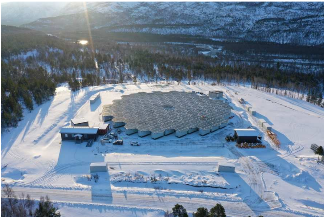
Figur 13.8 EISCAT 3D I Skibotn februar 2023. Anlegget består av 100 containere med elektronikk som hver skal betjener 100 antenner på taket av containeren. Til sammen blir det 10 000 antenner. Disse er nå montert og under innkjøring (2024). Foto: https://eiscat.se
