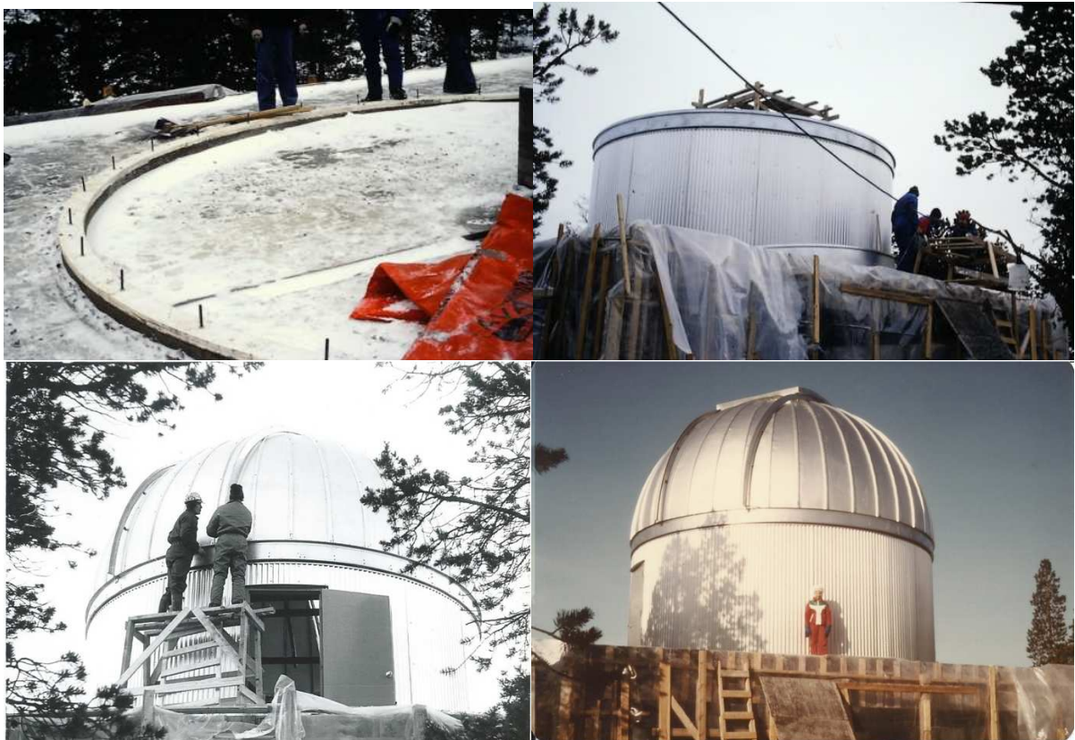
Figur 3.11. Montering av kuppel fra Ash Domes, Øverst til venstre monteringsring for kuppelbygget på observasjonstaket. Øverst til høyre er den sylindriske delen av kuppelbygget satt på plass. Nederst til venstre er selv kuppelen montert og det arbeides med spalteåpningen. Til høyre er kuppelen ferdig. Foto: JES
