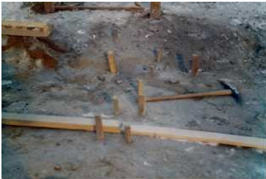
Figur 3.8. Her lages hull for feste av teleskopfundament til fjellet.
