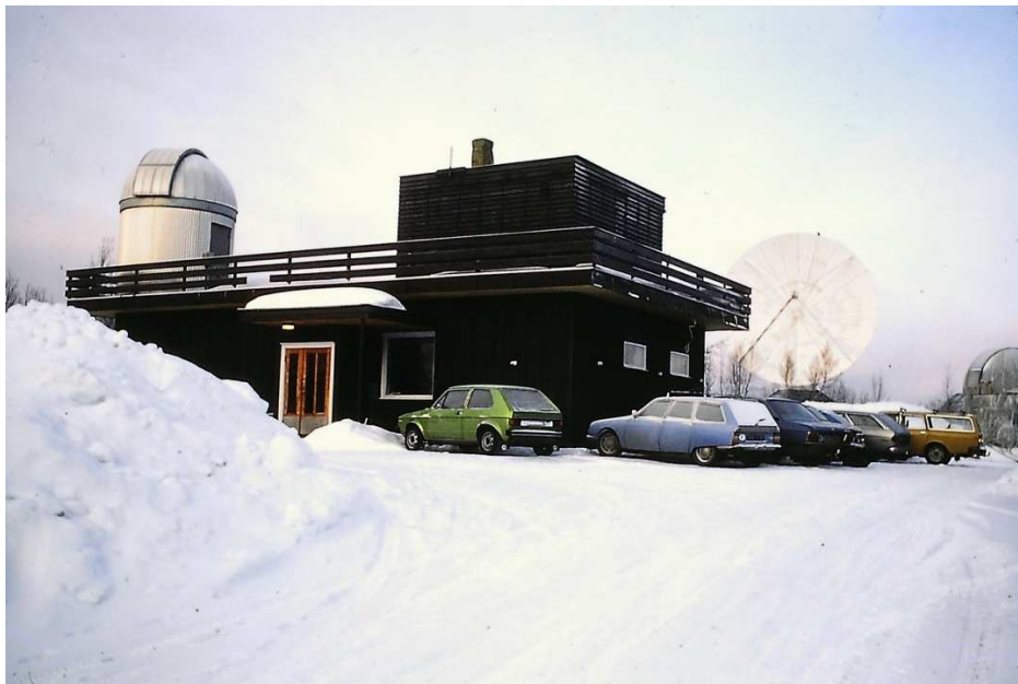
Figur 2.2. Optikkbygget rett overfor Gamlebygget. Det hadde flatt tak for oppstilling av instrumenter og en hes for å frakte disse opp på taket. I bakgrunnen ser vi noen av antennene til Tromsø Satellittstasjon som ligger til høyre utenfor bildet. Helt til høyre kuppelen til Holmboeteleskopet.
