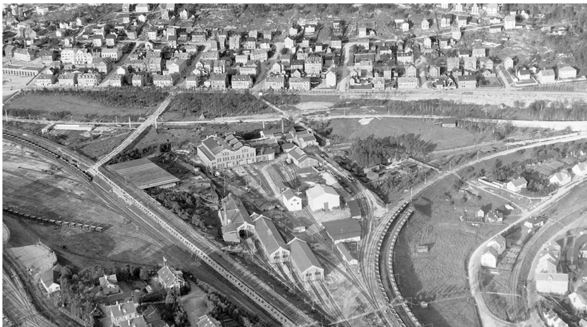
Figur 4.5. Flyfoto av verkstedtomta fra 1937 med bydelen Oscarsborg i bakgrunnen. Tomta avgrenses av Fagerneslinja mot Oscarsborg, Nedrelinja til venstre går mot utskipningskaiene og Forbindelsessporet som går i bue til høyre i bildet. Lokstallene nærmest og lokverkstedet med maskinverkstedet bakenfor. Foto: Narvik komm. fotosamling.
