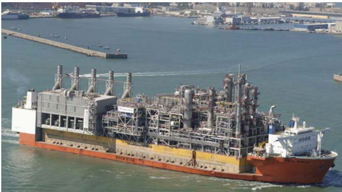
Bilde 5.1: Prosessanlegget bygd på lekter, bildet viser transporten til Melkøya (www.statoil.com)
