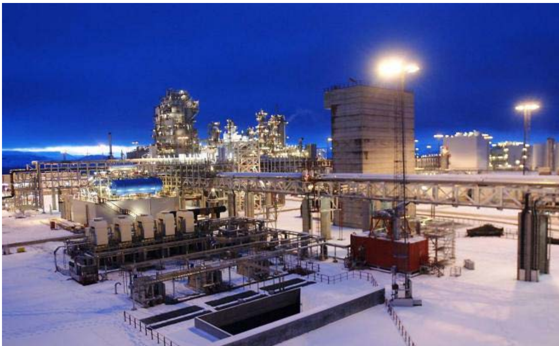
Bilde 4.4: I forgrunnen: kraftgeneratorene. Tårnet litt til høyre i bildet er kjøletårnet (www.statoil.com)
