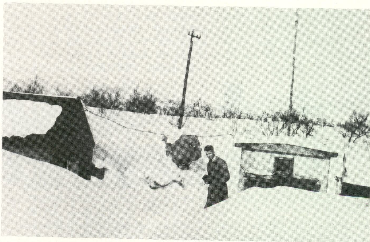
Dette er et bilde av observasjonsplatået tatt fra taket av observatoriet i april 1941. Til høyre for Kåre Langlo er koblingstavle for varmestrøm til spektrografene. På tavelen hadde en også tilkoblingsboks for telefon som ble brukt under samtidig fotografering av nordlys i Tromsø og på Tennes i Balsfjord (som Steinar Jensen tok seg av). Til venstre for Langlo stikker en spektrograf frem av sneen, de andre instrumentene er helt dekket av sne.
