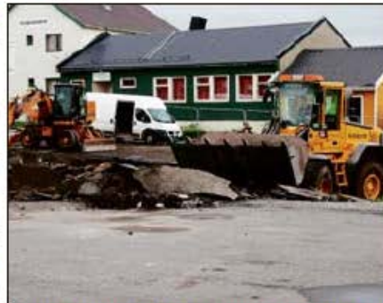
IGANG: Nå har klaringslaget for flerbruks huset gått, og arbeidet er i gang med å grave ut tomte.
