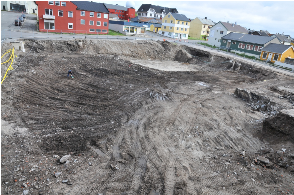
Figur 3 Tiltaksområdet ved start av overvåkingsarbeidet
