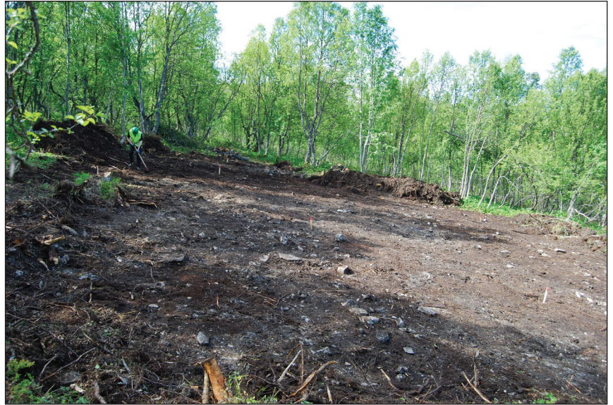
Figur 102. Ferdig avdekket utgravningsfelt, fotografert mot vest.
