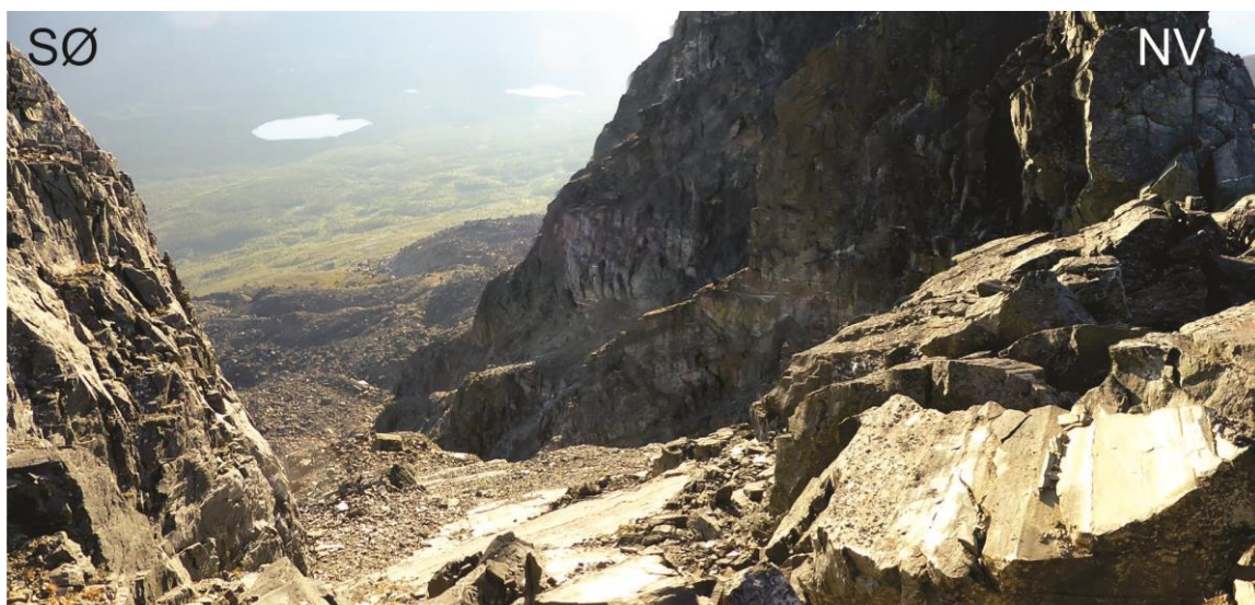
Figur 4.17 Foto av slakt hellende NV-SØ strykende sprekkeseitt observert langs fjellryggen i nordvest. Dette avgrenses av bratt hellende NØ-SV strykende sprekkeseitt med steilt fall til høyre og venstre for slakt hellende sprekkeseitt i bildet. Merk opptreden av løst materiale langs overflaten av slakt hellende sprekkeseitt.
