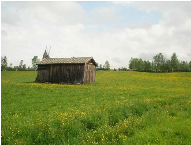
Fig. 5.8: Restaurert laue med skifertak i Småsetran. Foto: Anja Øren.
