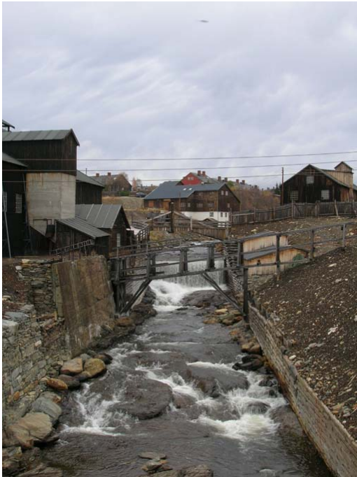
Fig. 5.1 : Til venstre er smelthytta, det nåværende Rørosmuseet. Grunnlaget for plasseringen kommer tydelig fram på dette bildet, med fossefallet i Hyttelva midt i bildet. Foto: Rune Floor.
