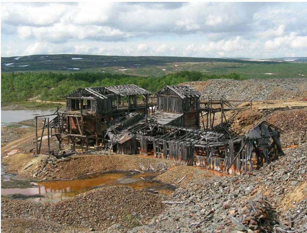
Fig. 5.11 : Taubanestasjonen ved Christianus Sextus gruve i Nordgruvefeltet, ikke langt fra Kongens gruve. Foto: Rune Floor.
