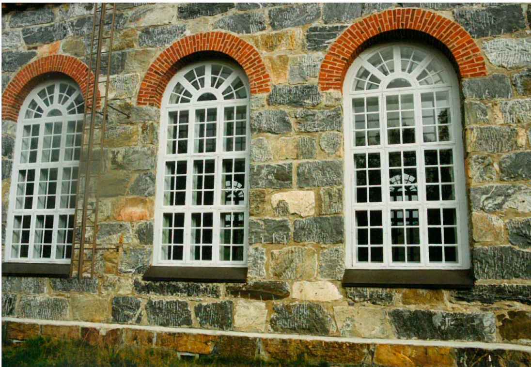
Fig. 19: Utsjok kirke. Vinduer ved langvegg. Foto: Silvana Elisabeth W. Granlien
