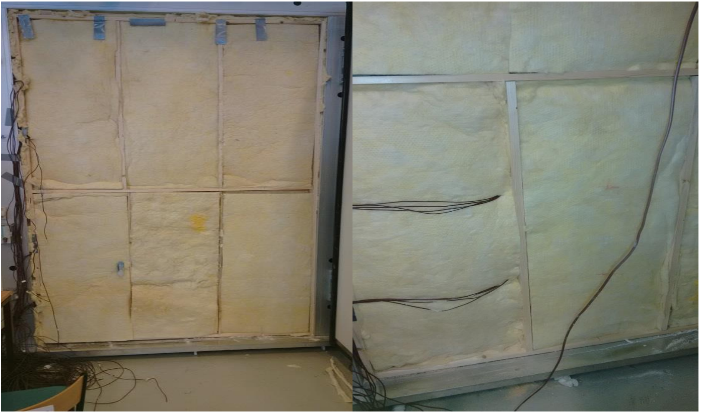
Figur 58. Isolerings prosessen av veggen. Bildet er tatt av M Anwar
