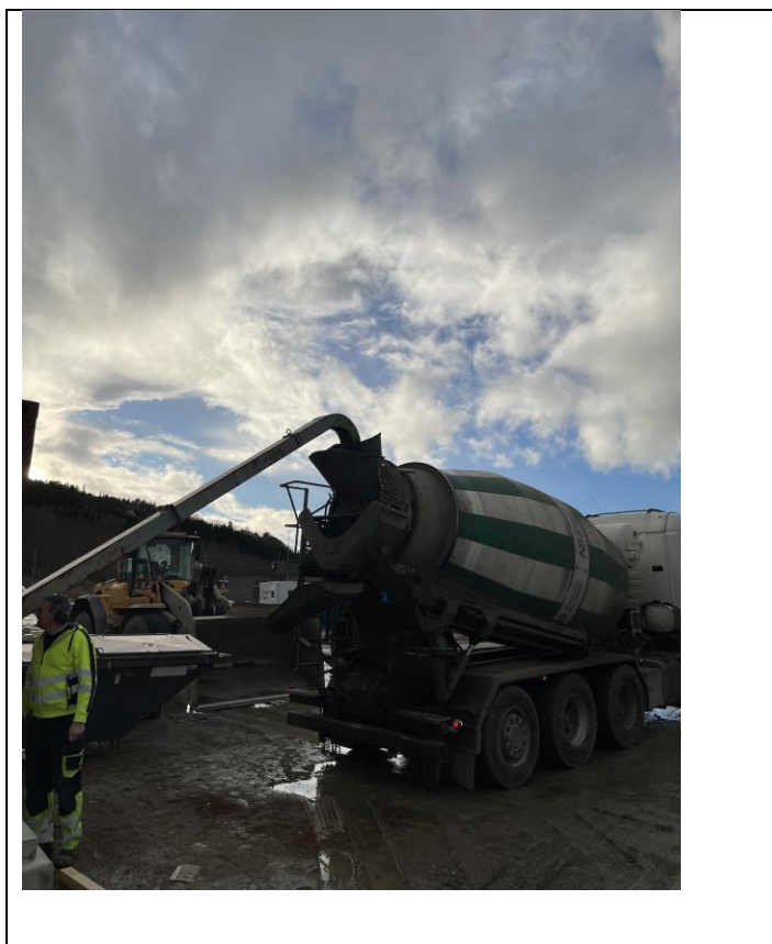
Figur 20: Trommel og fiberdoseringsmaskin i Fauske
